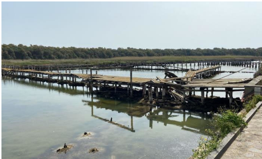
Strutture fatiscenti in legno e presenza di materiale accumulato sul fondo del canale
