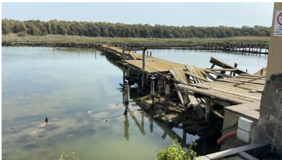
Strutture fatiscenti in legno e presenza di materiale accumulato sul fondo del canale
